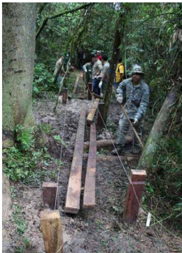
Figura 2. Guardaparques del curso construyendo un sendero en Reserva Natural de Mbaracayú.
